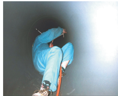
Figure 11 – Mise en place du porte source dans une tuyauterie. Installation of the source holder in a pipe.
